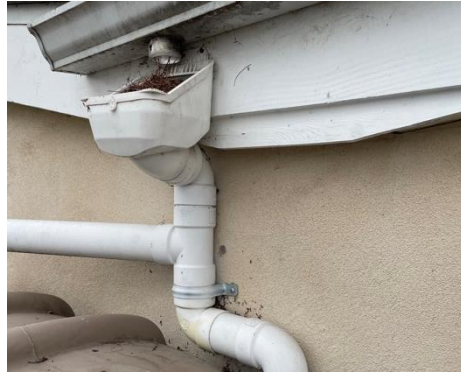
Descripción general de la planificación e instalación
